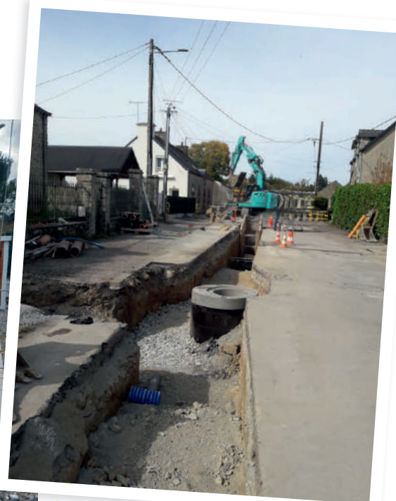
Réhabilitation des réseaux d'eau potable et des eaux usées, rue du Stade : canalisation en grès
