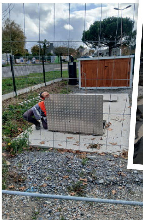
Poste de refoulement installé rue St Fiacre
